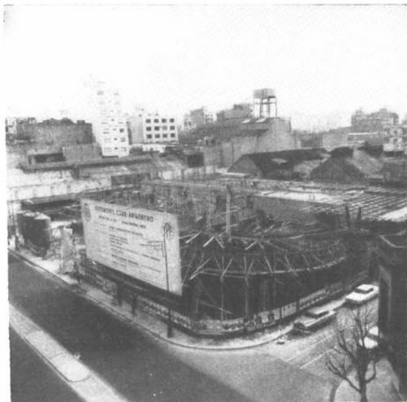
Vista general tomada cuando estaba visible el encofrado del entrepiso, el del primer piso y el de la parte inicial de la rampa.
