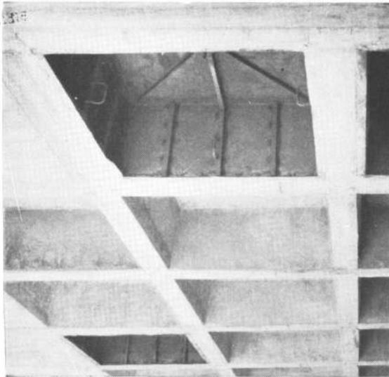
Moldes metálicos de chapa de acero doble decapada de dos milímetros de espesor que se usaron para el sistema de casetonado. Se los extrae por aire comprimido que penetra por una válvula en su centro.
