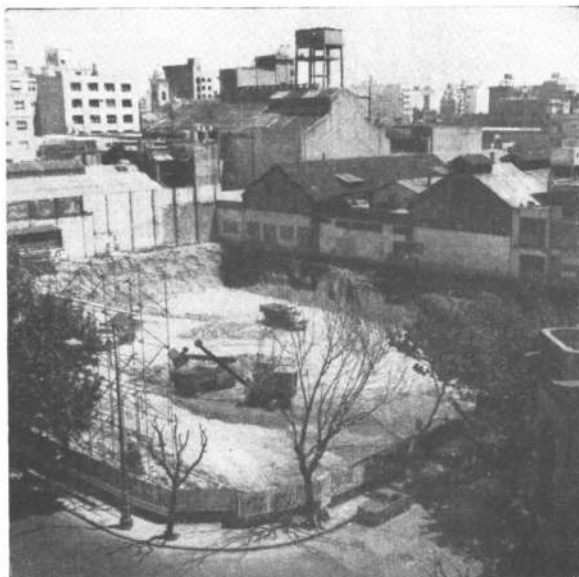
El volumen de la excavación que hubo que hacer en el terreno de Rivadavia y Agüero fue de aproximadamente 28.000 m. cúbicos.
