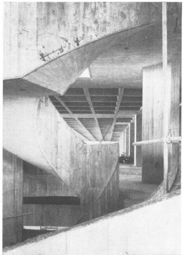
Vista de detalle del núcleo de escalera que asciende en el hueco que dejan las rampas en su desarrollo. Se tomó desde la interna.
