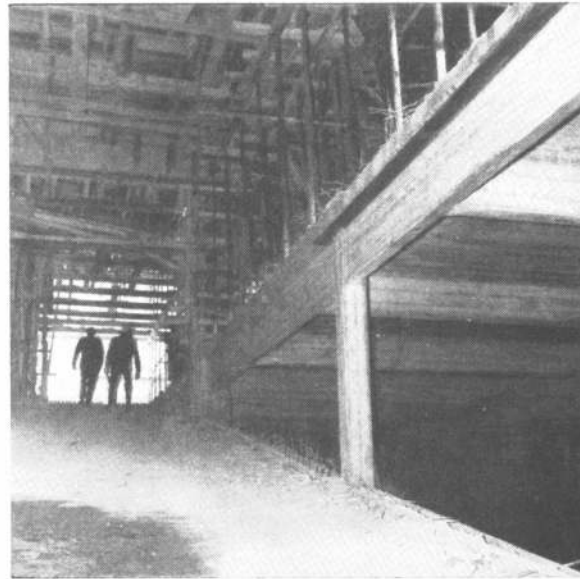
Rampa de servicio de acceso al subsuelo, cuyas vigas simples se ven en la foto, con salida hacia la calle transversal a Rivadavia.
