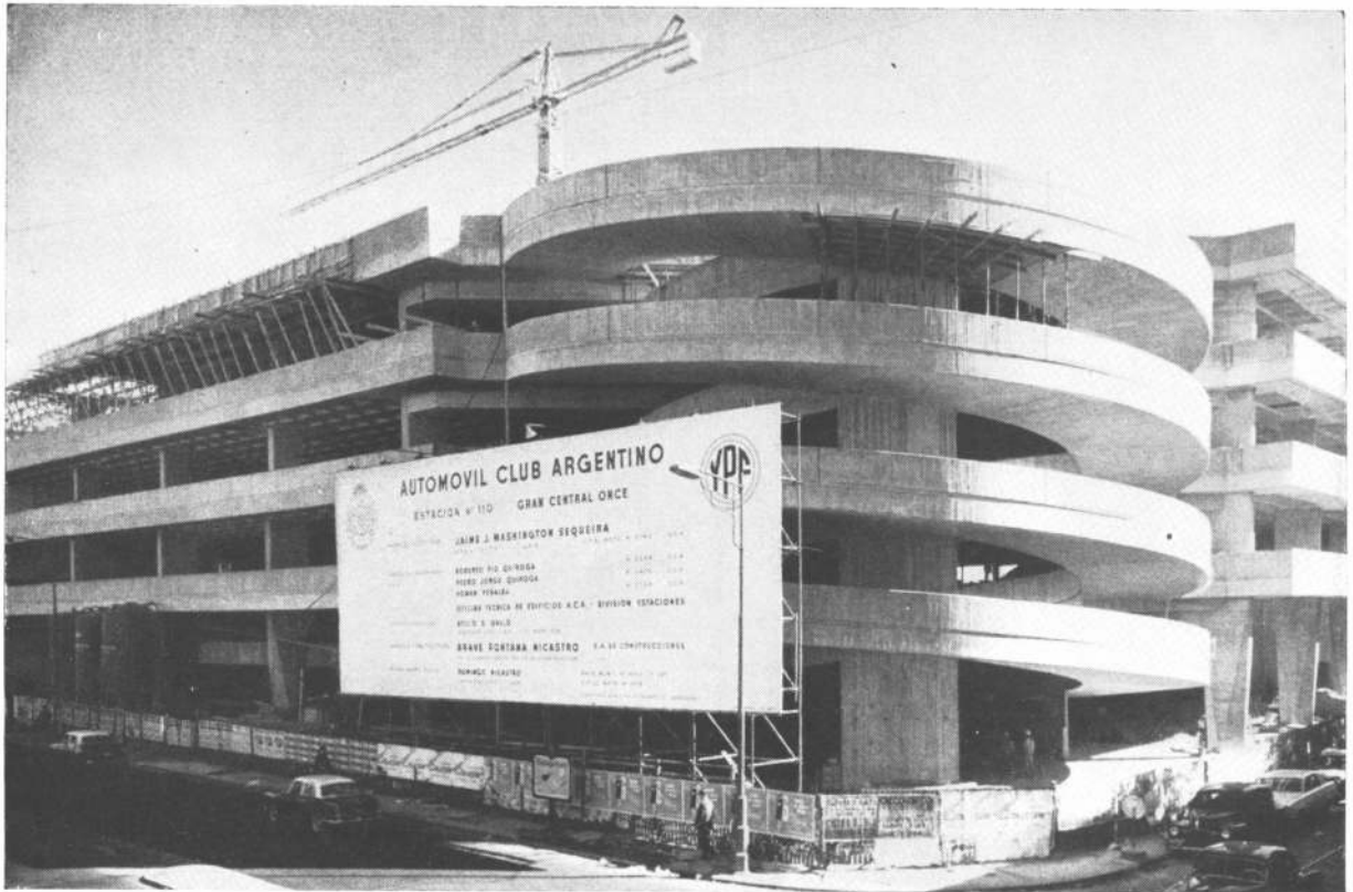
Una fotografía del edificio tomada cuando terminaban las tareas del hormigonado. Se ven las rampas helicoidales ascendente, afuera, y descendente, adentro. Más atrás, se observa las grandes playas con hormigón casetonado que se prolongan por ambas calles.
