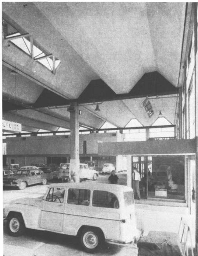
Vista interna del plegado con el tímpano lleno sobre las columnas centrales y el tímpano calado al fondo. Ancho del techo: 36 metros.
