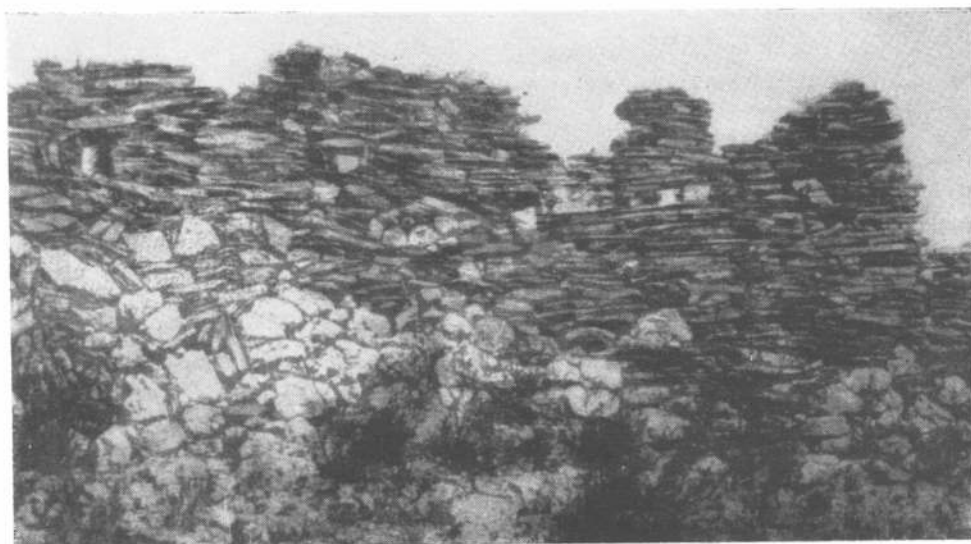
El muro de pirca es el símbolo constructivo indeleble de las civilizaciones prehistóricas; en algunos casos utilizaban barro aglomerante pero, en general, trabajaban "en seco" siendo de notable calidad la composición y el equilibrio con que se ejecutaban.
