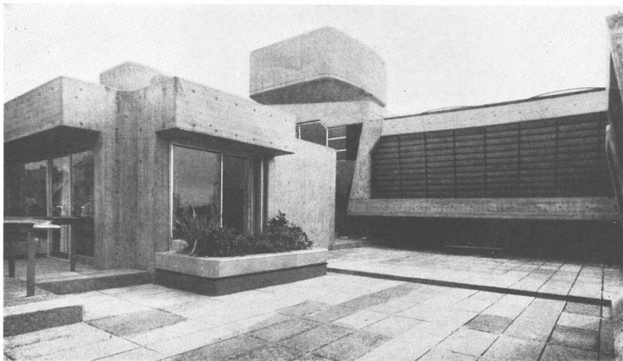
Vista de una de las torres de enfriamiento, en la azotea del edificio del banco de Londres. Su apariencia exterior fue debidamente cuidada para que el conjunto no desentonara con el resto del edificio y para que compusiera su parte en el conjunto arquitectónico.
