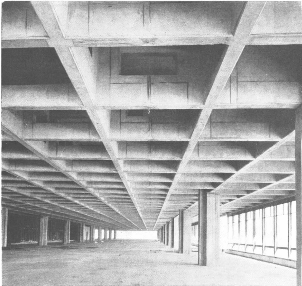
Los casetones se repiten por toda la planta; obsérvese cómo los calados de sus paramentos verticales se reducen (el último no es más que un círculo) llegando a la proximidad de la columna. Abajo: el nivel inferior (subsuelo) quedará tapado con movimiento de tierra.
