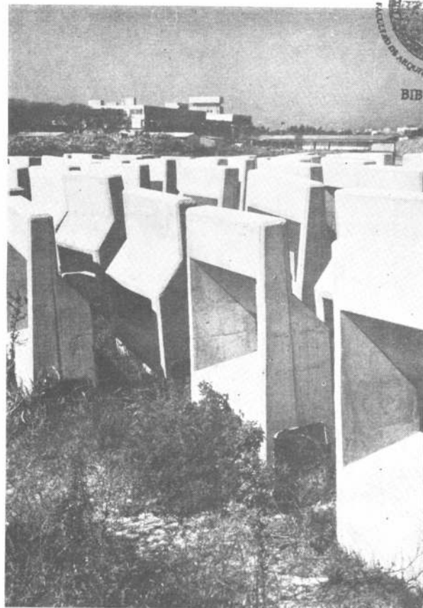
Troncos de pirámide de 4 por 4 por 2,10 metros cubren el patio central que es de 32 por 36 metros. Derecha: parapetos premoldeados de hormigón armado para la azotea agrupados al pie de la obra. Abajo: planos de hormigón armado juegan en la escalera principal.
