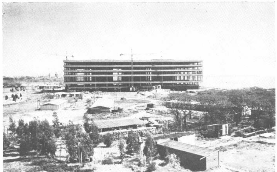
Los rieles para la enorme pluma circundan el edificio. Abajo: vista general de la estructura con las dos grúas, casillas para oficinas, montañas de piedra y arena. El Río de la Plata a la derecha.
