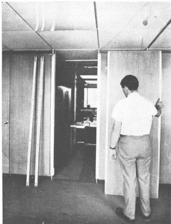
Panel desmontado a la derecha; a la izquierda, dos tubos, cada uno con los cuatro ojales de ajuste y las ranuras de colocación.
