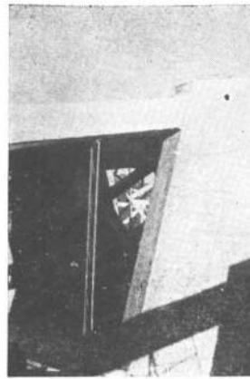
La unión del arco hormigonado y la parte alta del pórtico.
