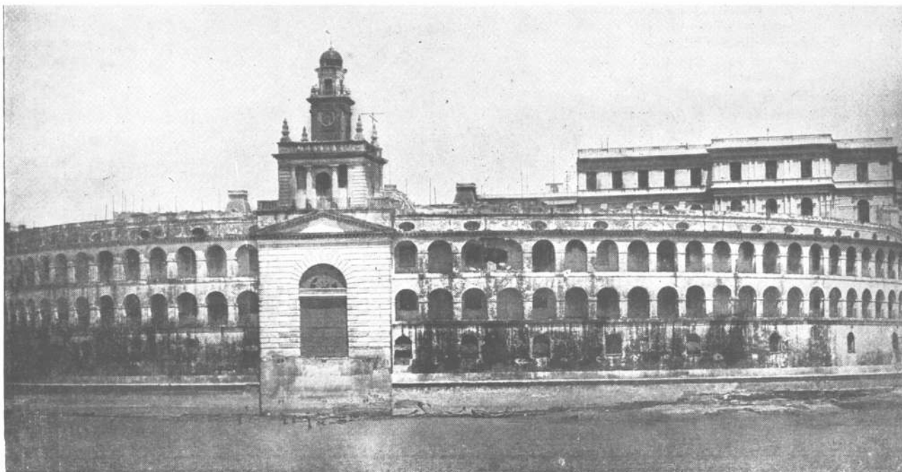
12. La Aduana Vieja, obra del arquitecto inglés Eduardo Taylor, circa 1884, ya retirado el muelle de cargas (fotografía Lunström).
