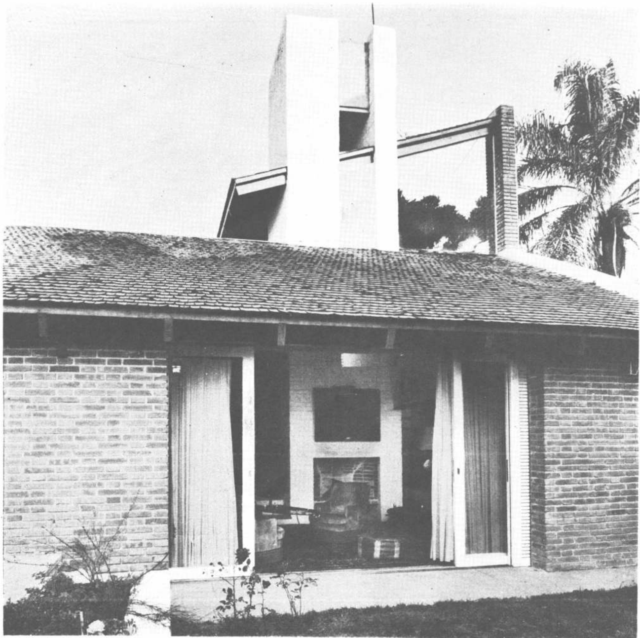
Arquitecto: Félix Ruiz Martínez. Propietario: familia Hillblad. Ubicación: Borges 1189, Olivos, provincia de Buenos Aires. Superficie del terreno: 300 metros cuadrados. Superficie cubierta: 150 metros cuadrados. Año del proyecto: 1959. Fotografías tomadas por Lepley. Amueblamiento a cargo del propietario.
