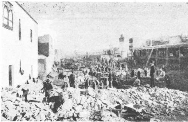
1889. Vista de los trabajos de demolición que se encararon para abrir la Avenida de Mayo y que motivaron el cercenamiento de 3 arcos del Cabildo (ver na 409, diciembre 1963: "El Cabildo de Buenos Aires").
