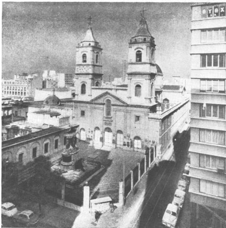
Aspecto actual de Santo Domingo. Adviértase la fundamental diferencia de esta imagen con la litografía de Pellegrini. El frente actual es obra de los constructores Plou y Oliver (1894). La torre derecha fue agregada en 1849.
