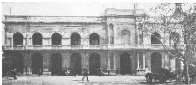
3. Fotografía tomada alrededor de 1913, que muestra la torre tronchada y la disposición asimétrica impuesta por la apertura de la Avenida de Mayo.
