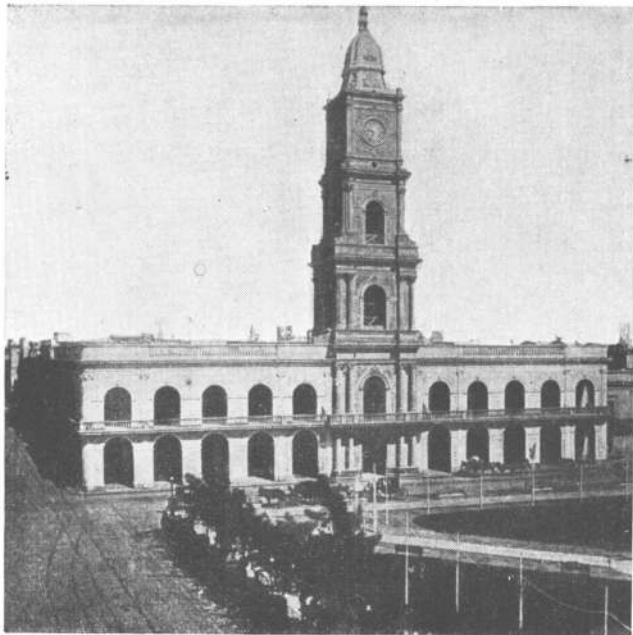
2. Fotografía tomada alrededor de 1882, que muestra el aspecto durante el periodo 1880 - 1890 en que se elevó la altura de la torre y se refeccionó el edificio a la manera académica.
