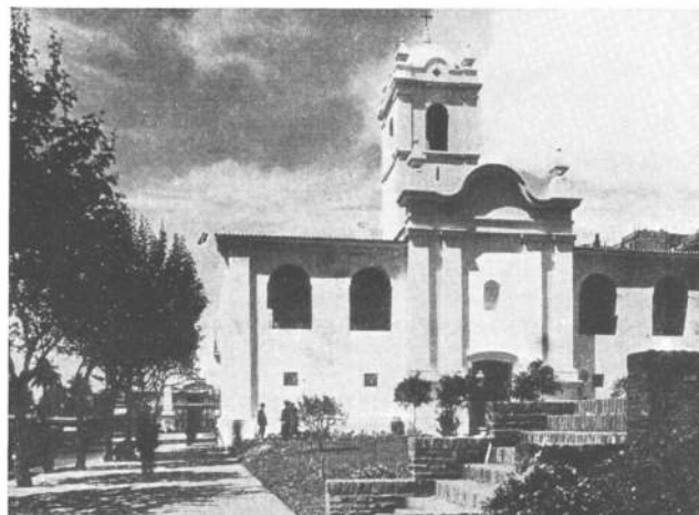
5. Aspecto que ofrecía hasta 1960 la parte posterior del edificio restaurado en 1940. Hace tres años se levantaron edificaciones sobre esta parte obliterando el interesante espacio urbano que muestra la fotografía.
