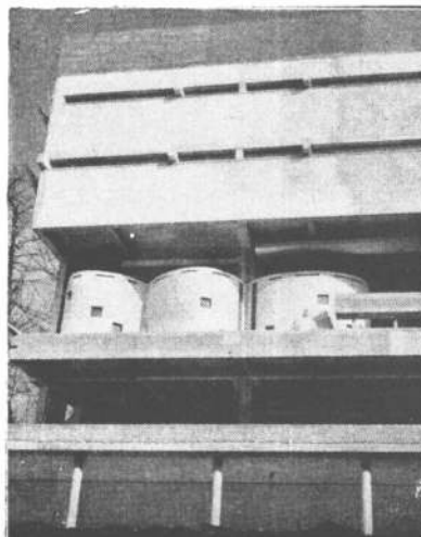
Le Corbusier: La tourette; detalle del edificio este visto desde el corazón del conjunto.
