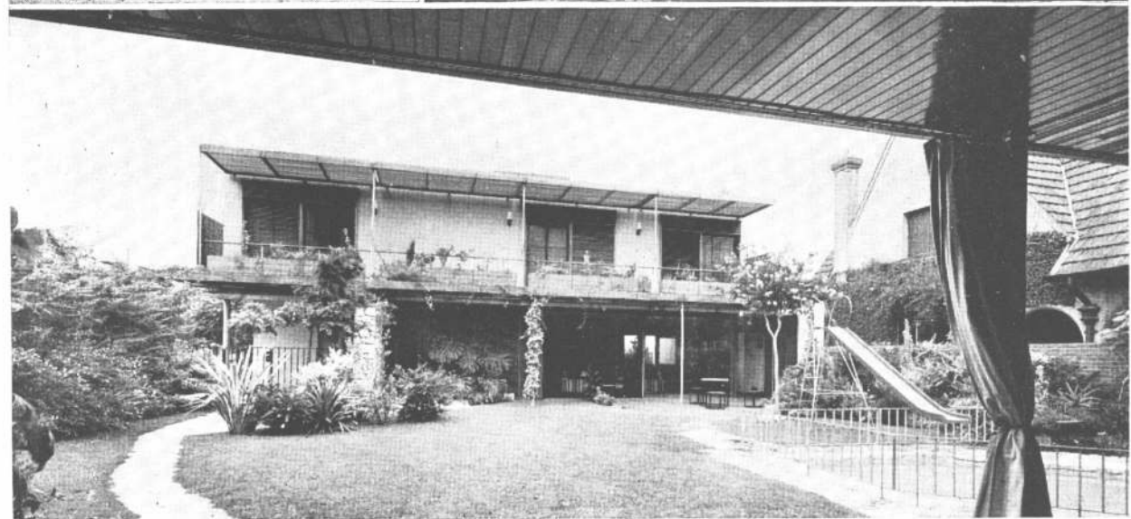
1. Sector de fachada desde la puerta de la cochera; la pequeña puerta da acceso a la calle desde el escritorio. 2. El acceso principal. 3. Un muro da intimidad a buena parte del jardín. 4. Al fondo del jardín, un pabellón con parrilla y cortinas que pueden cerrarlo completamente; en el centro del jardín, una pequeña pileta para niños; toda la zona de estar vincula con el jardín. 5. La casa abre hacia el jardín.
