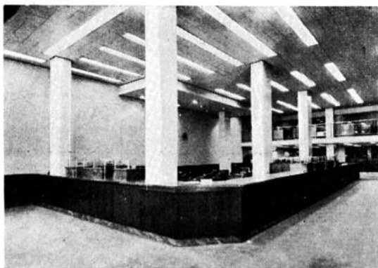
Vista interior del Banco Internacional.
