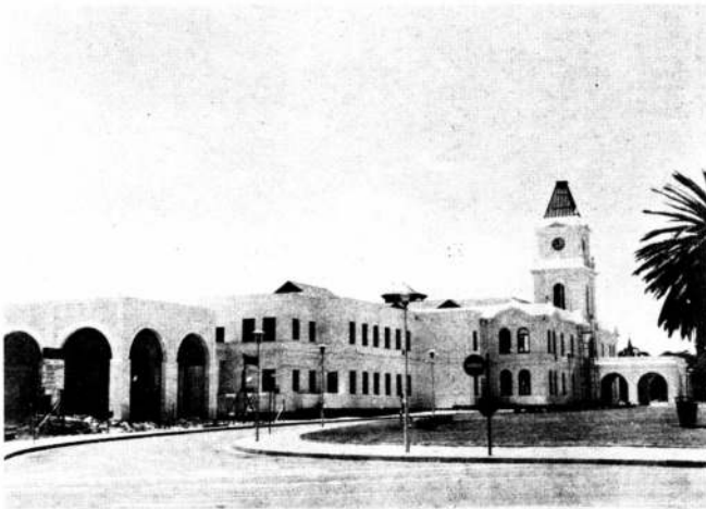
Arriba. Maqueta del centro Cívico Krugersdorf (Sudáfrica). Abajo izquierda. Centro Cívico Krugersdorf en construcción.
