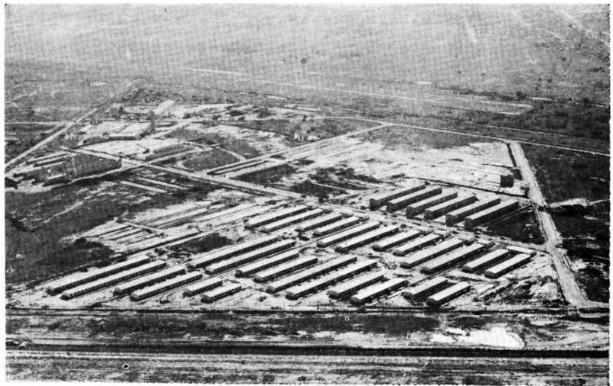
Construcción de viviendas por FONAVI en el sector S.O.
