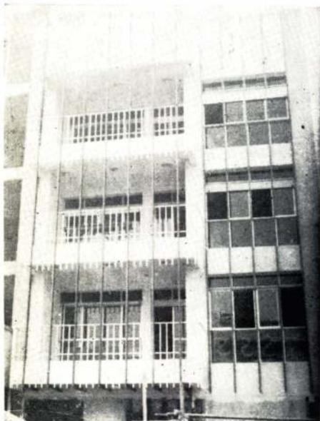
**OBRA: SOIVA** Carpintería con premarco de aluminio, taparrollo exterior, eje de cortina, guías y levanta cortinas unificados (funcionando antes de estar amurados). Baranda en tubos aluminio anodizado bronce.
