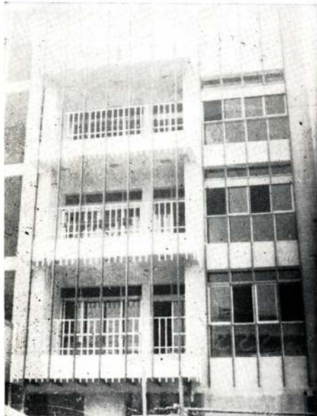
OBRA: SOIVA Carpintería con premarco de aluminio, taparrollo exterior, eje de cortina, guías y levanta cortinas unificados (funcionando antes de estar amurados). Baranda en tubos aluminio anodizado bronce.
