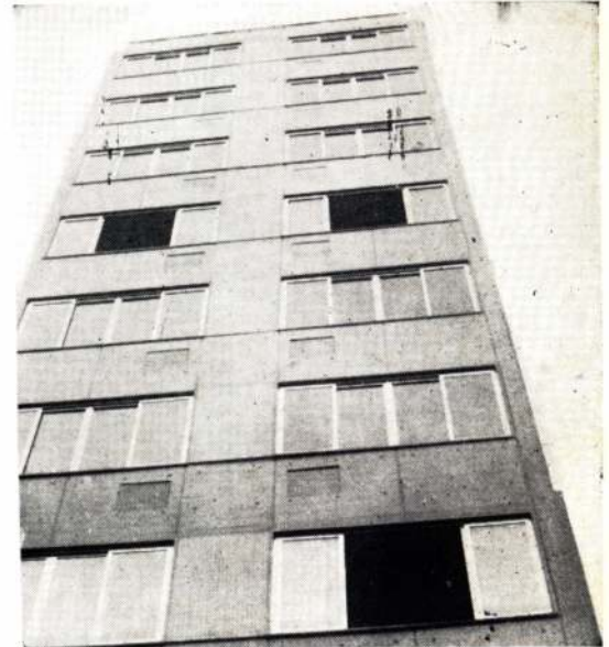
OBRA: Centro de Constructores O.S.N. Hojas corredizas con premarco de aluminio y premarco de chapa de fe.
