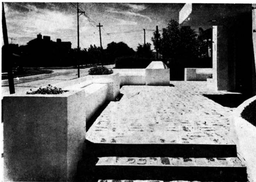
Acceso a la iglesia. El juego de planos rectos y el tratamiento dado a las paredes blanqueadas a la bo'sa reflejan la sencillez y modestia buscadas.
