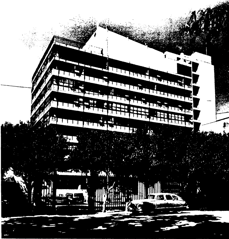
Edificio para oficinas y club Lugar: Churubusco, DF, México Arq.: Manuel Rosen Morrison
