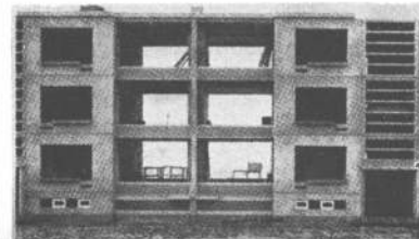
Por montaje de grandes elementos (abajo).
