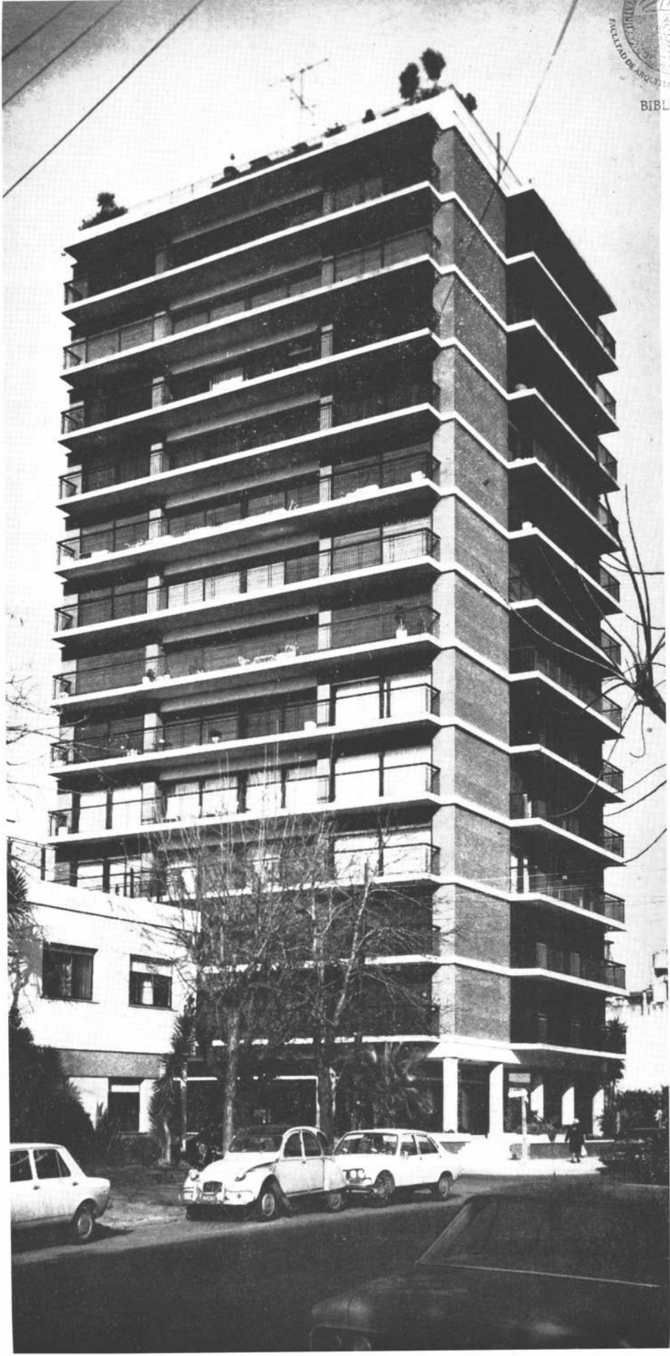
Vista lateral del edificio con frente al N.E.
