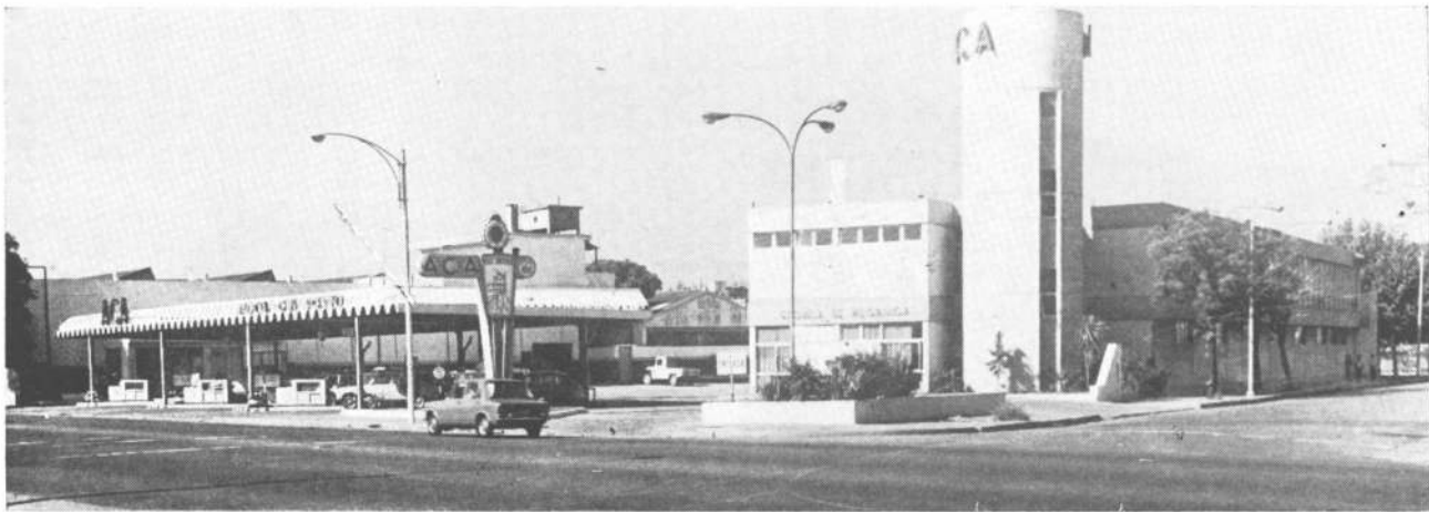
En página opuesta: Vista angular de las instalaciones de la Escuela de Mecánica del ACA. Arriba: detalle de los tres cuerpos que componen el edificio y vista general de las instalaciones.
