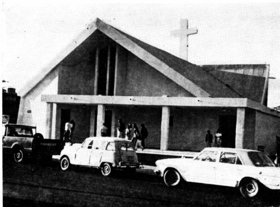
Arriba: El acceso principal se encuentra protegido por una galería dada las características climáticas de la región patagónica. Exteriormente, el edificio fue terminado con material de frente salpicado color blanco.
