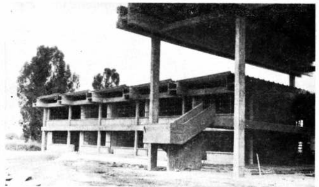
En la foto de arriba se ve la escalera de hormigón armado autoportante. Se aprecia también el tratamiento del módulo y la carpintería de perfil de hierro de doble contacto. Abajo, detalle de la estructura compuesta por columnas y vigas de hormigón armado. La viga en forma de H sostiene el doble techo y forma canaleta para el desagüe de las lluvias.
