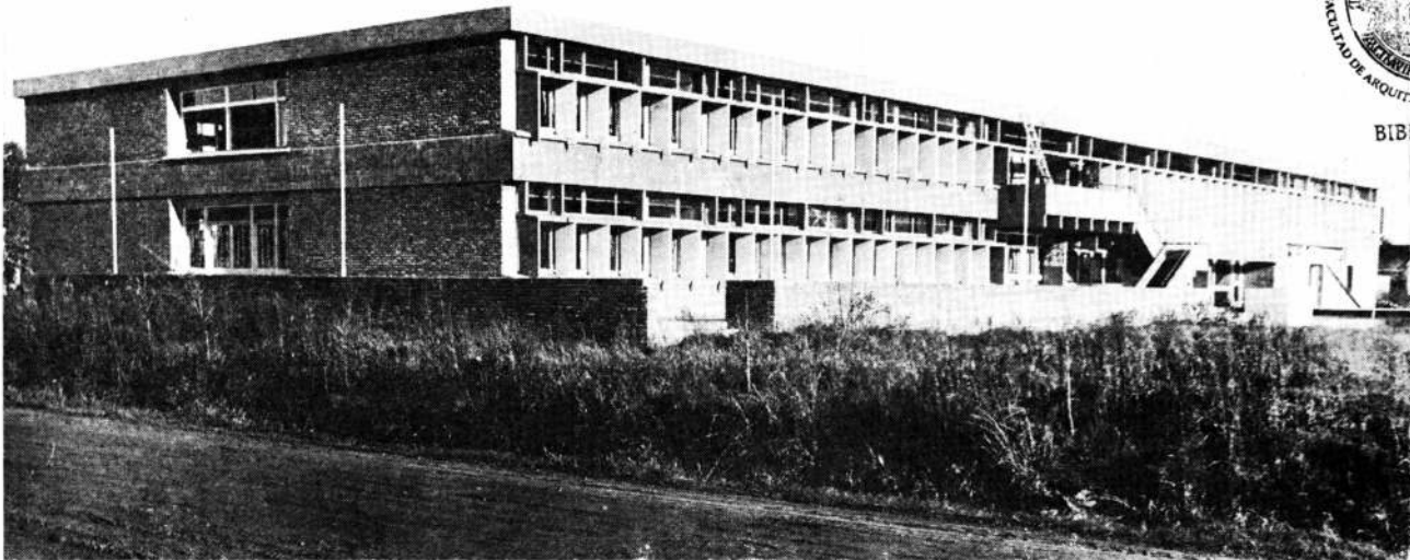
Vista general de la fachada posterior. Abajo, los parasoles fijos de hormigón modulados cada 1,20 metros dan fuerza a la expresión arquitectónica.
