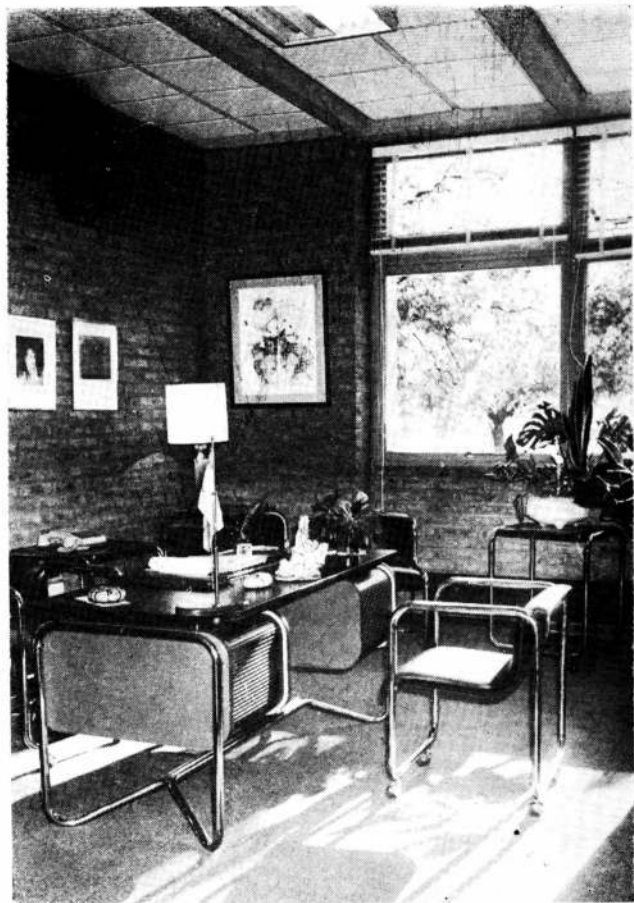
El interior de la Dirección. Puede verse el cielorraso de yeso estriado colocado entre el enviguetado. Este ha sido instalado también en las aulas. El tipo de carpintería empleada es con ventanas de proyección horizontal.
