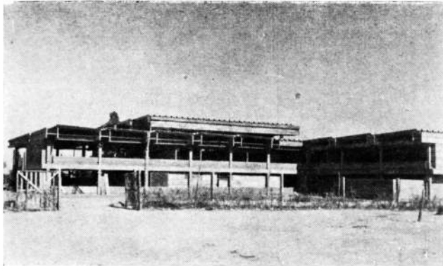
En la foto de arriba puede verse la fachada principal, durante la construcción, de la escuela "Manuel Belgrano", en Tarija, Bolivia. En la foto de abajo, en un enfoque parecido al anterior, se observa el doble techo de canalón de asbesto cemento y losa de hormigón armado enviguetada, para formar cámara de aire debido a las altas temperaturas de la zona.
