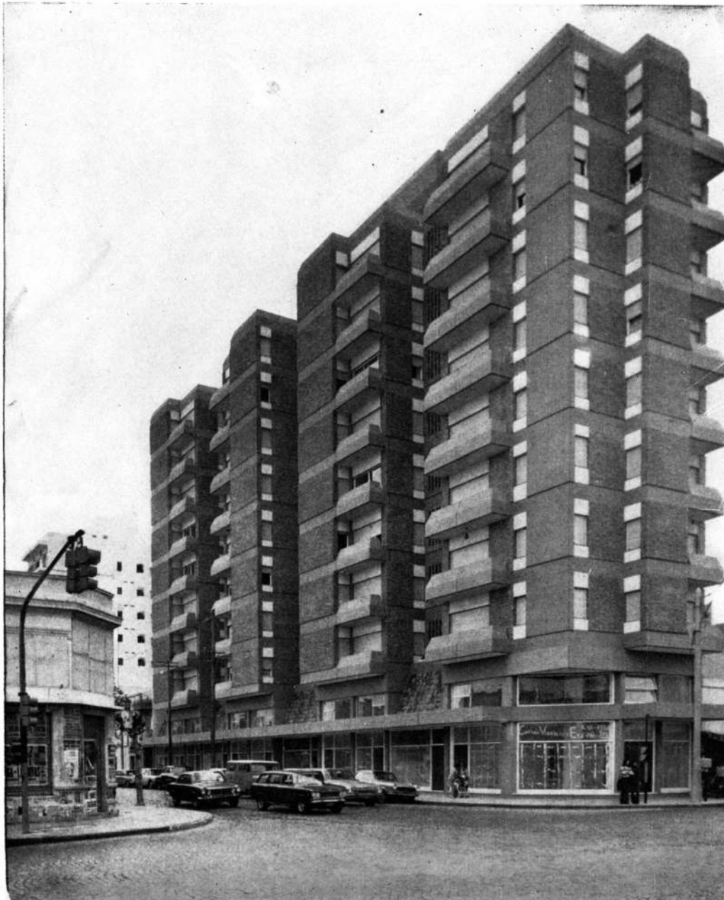
Vista del edificio desde la avenida Hipólito Yrigoyen
