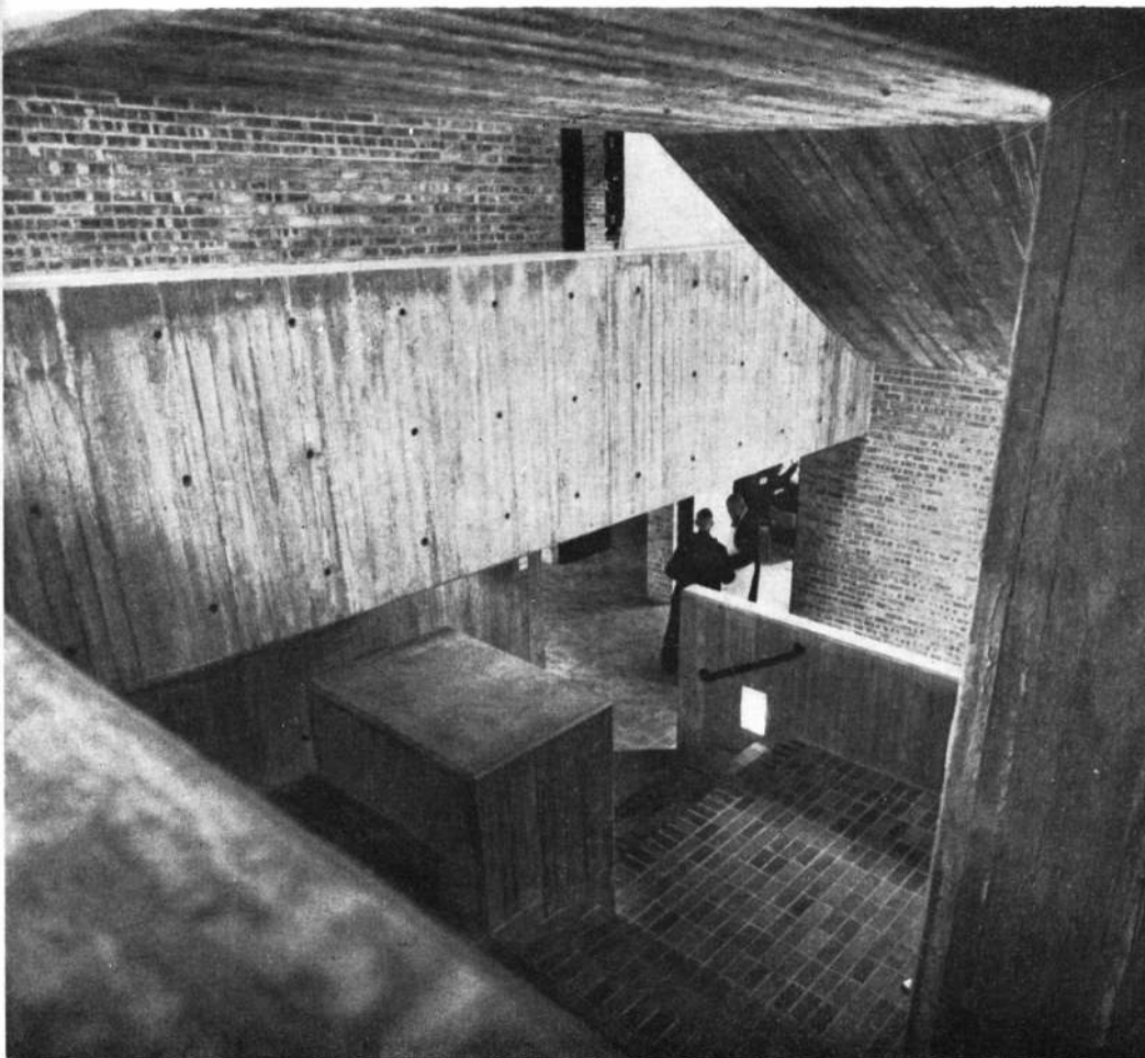
Los pisos de ladrillo a la vista y el hormigón con el trabajo del encofrado también a la vista, configuran un marco ascético.
