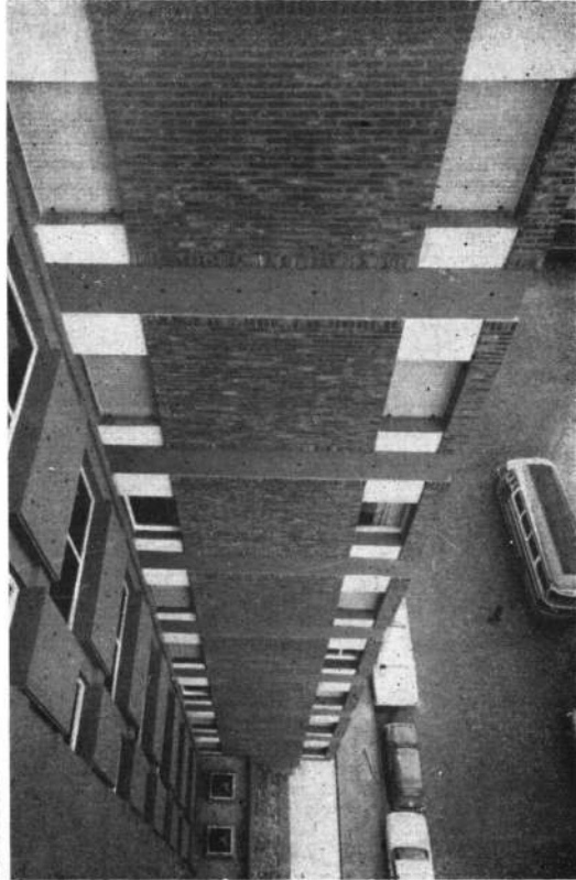
Vista parcial de la fachada hacia abajo, donde se aprecia las dos claraboyas acrílicas sobre el pasillo de acceso.
