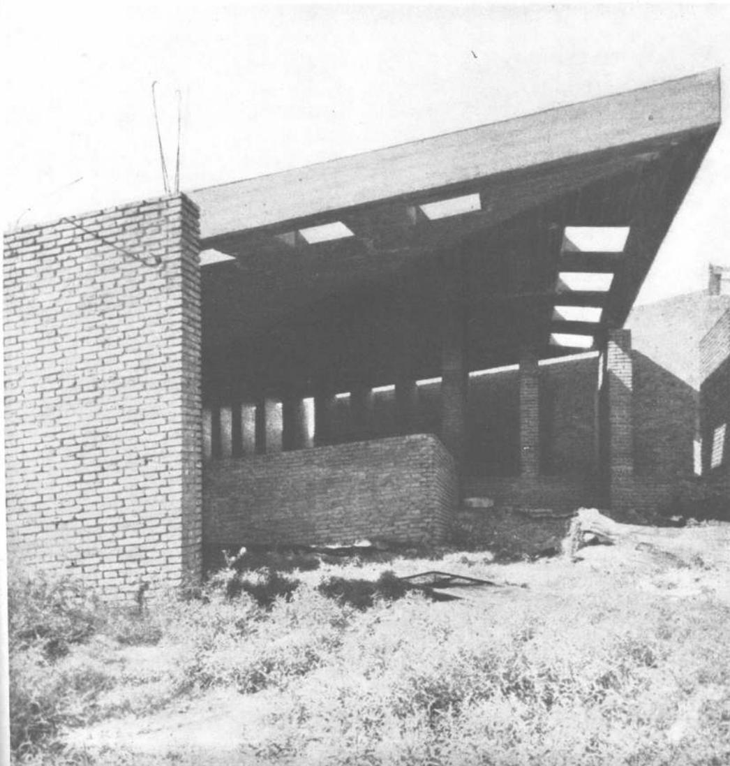
El techo está constituido por una losa de hormigón a la vista en dos aguas y su encofrado siguió la misma dirección de las paredes formando una nervatura en dirección al altar.
