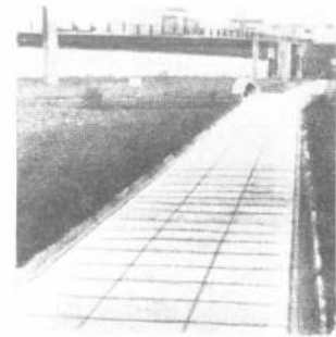
El sendero peatonal, de losetas de hormigón, está recorrido en todo su perímetro por la canaleta de desagüe, también realizada en hormigón premoldeado.
