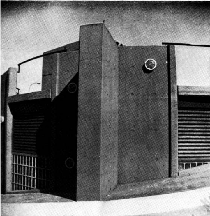
7: Remate de las rampas, en nivel cuarto piso, dando acceso a la amplia zona de estacionamiento. Allí también se ubicó la vivienda para el encargado de la estación.
