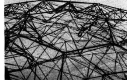
Domo de Fuller para la Expo'67. Cubierta para escuelas por el sistema S.C.S.D. Desarrollo de una cúpula reticulada armada en partes desplegables.
