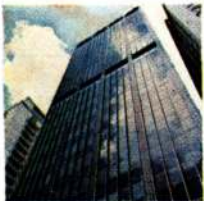
edificio St Georges, Hong-Kong, cristal "PARSOL" bronce
