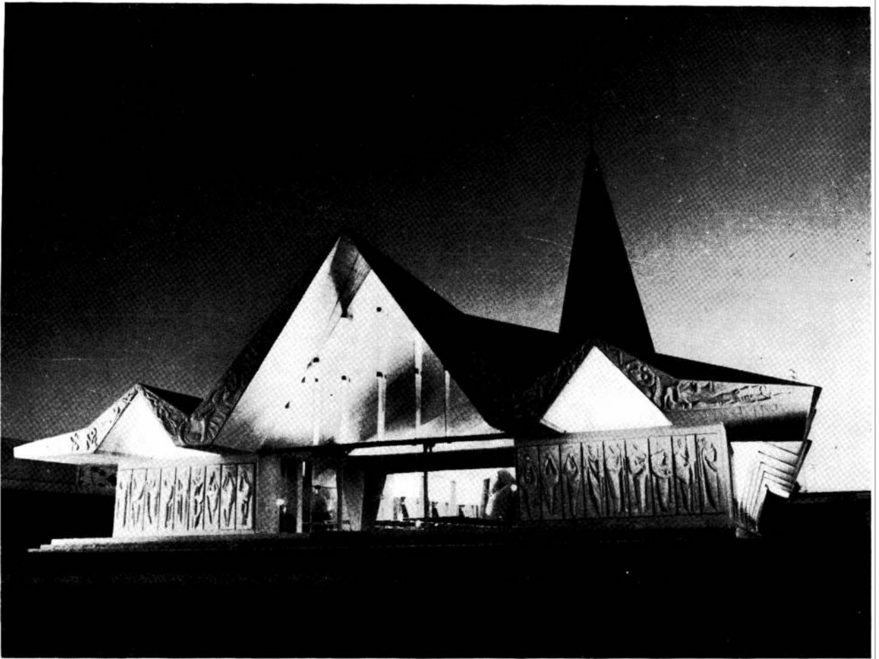
La iluminación nocturna destaca los relieves moldeados en el mismo encofrado de la estructura. Abajo: planta de la obra. Escala 1: 500.
