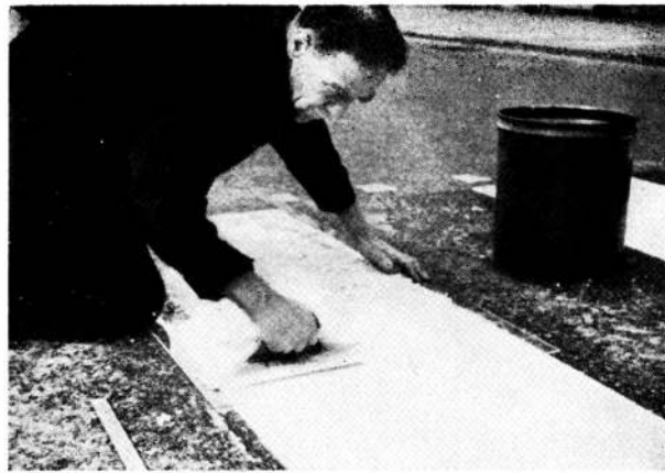
5.— Para probar la resistencia al desgaste de los compuestos a base de resinas epoxi, una "cebra de circulación" es ejecutada sobre una calle de Surrey, Australia.
