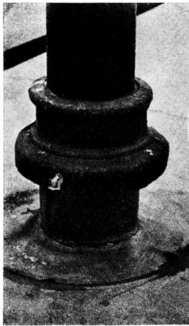
15.— El cubrejunta aplicado sobre losa y tubería asegura el correcto sellado entre ambos elementos.
