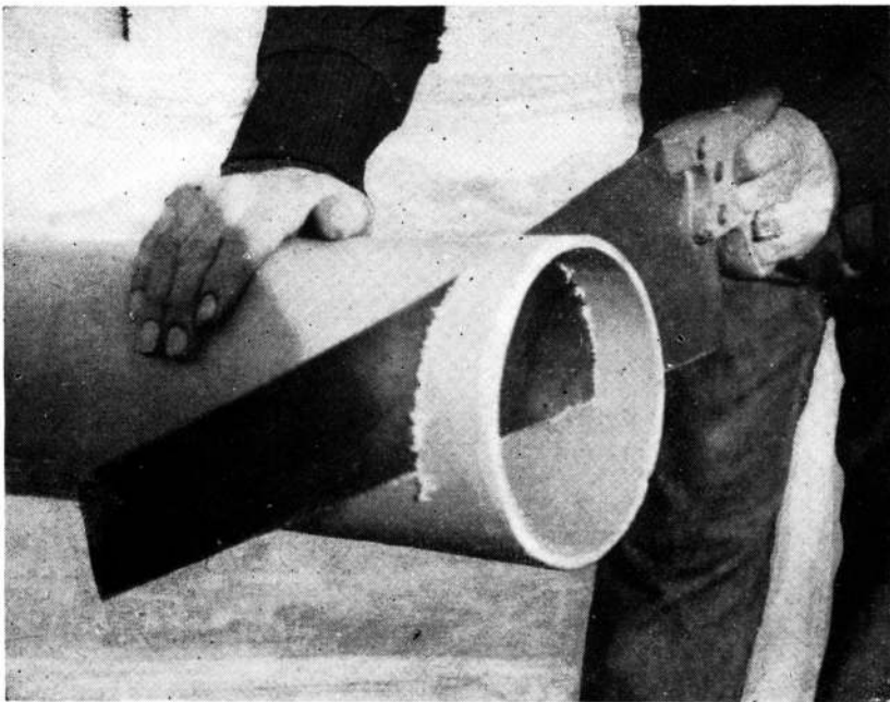
4: Cañerías sanitarias maestras de 45 centímetros de diámetro, realizadas en PVC, en el momento de proceder a su enchufe mediante pegamentos especiales.
