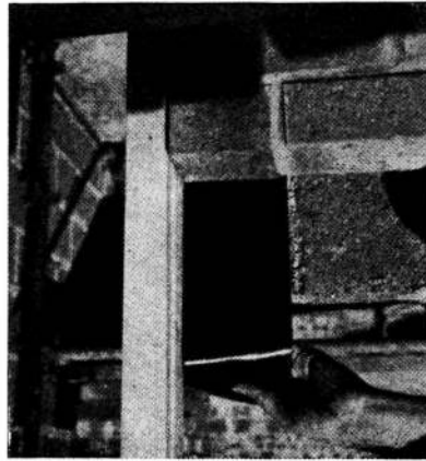
2.— El film de polietileno fijado con mortero se dispone entre fajas de ladrillo para la aislación hidrófuga horizontal y vertical.
