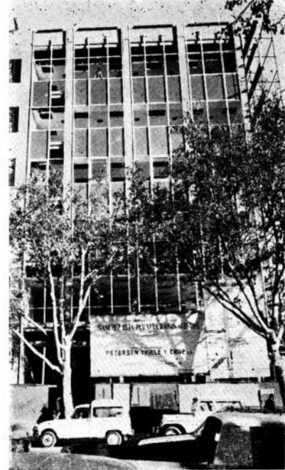
10: El City Bank Mendoza, de SEPR. Los paneles sandwich de fachada tienen cara externa de aluminio tratado con fluoropón y cara interna de placas de fibra extrudada;
