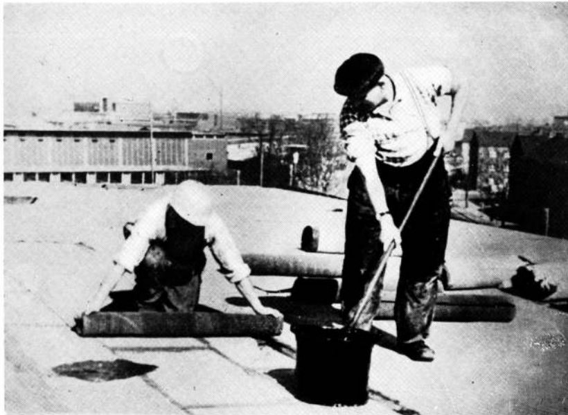
d: preparado del poliestireno expandido en techos.
