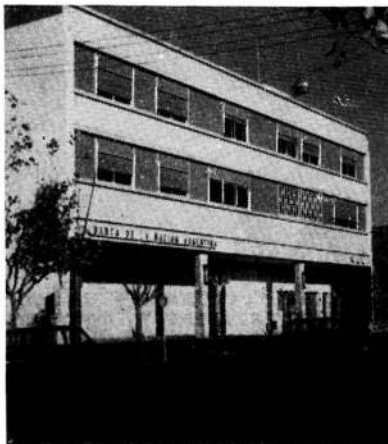
15: Banco Nación de Cipolletti. Paneles sandwich con las dos caras en fibrocemento, habiendo sido pintada la exterior;
