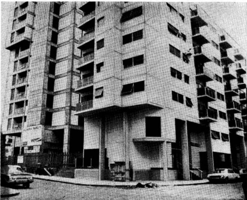
Secuencia fotográfica tomada desde la esquina de Yerbai e Hidalgo mostrando la relación entre la primera de las tres torres y el sector de "tira" ya terminado.
