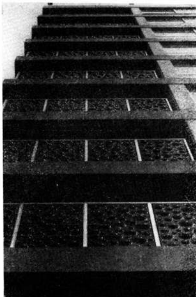
el tanque de bombeo, diseñado por el arquitecto Juan Gabriel Brusco, es exaltado como elemento escultórico.
