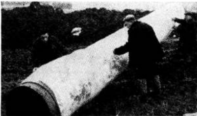
3.— El forrado de polietileno preserva la tubería de la agresividad del suelo.
