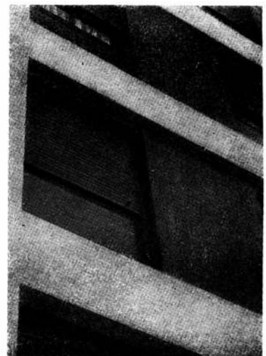
12-13: En el Conjunto Residencial Vicente López (Aslán y Ezcurra) se utilizan antepechos-sandwich con ambas caras en fibrocemento.
