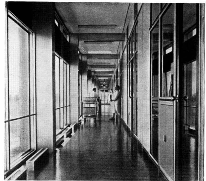
1.— Con el fin de preservar una estricta higiene con un fácil y económico mantenimiento, puertas y paneles de madera y metal se recubrieron con pinturas epoxídicas en los laboratorios de Parke Davis de Michigan.
