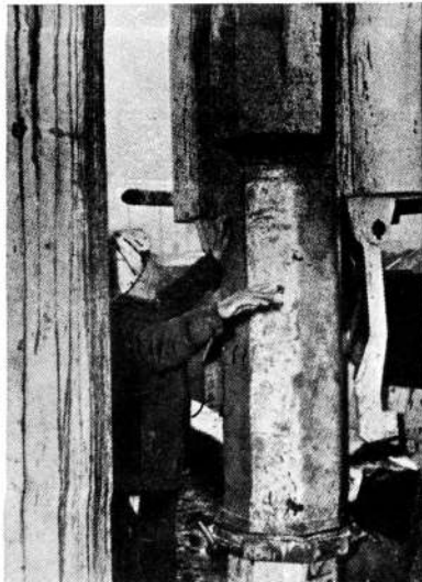
3-4.— Ante la necesidad de hincar pilotes a 27 metros y medio y contando únicamente con unidades de hormigón armado de 18,30 metros de largo máximo de fabricación, los profesionales responsables del Centro Cultural de Melbourne vincularon las secciones desiguales mediante adhesivos epoxídicos.
