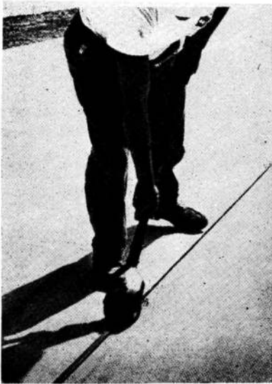
11.— El sellado de neopreno se instala en la junta mediante un rodillo.
