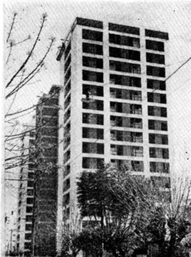
12-13: En el Conjunto Residencial Vicente López (Aslán y Ezcurra) se utilizan antepechos-sandwich con ambas caras en fibrocemento.
