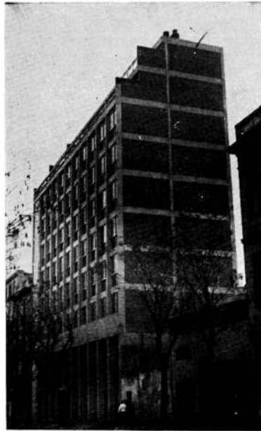
14: La Asociación Carmelitana Femenina Argentina (Arq. Ricur). Paneles con las dos caras externas en fibrocemento.
