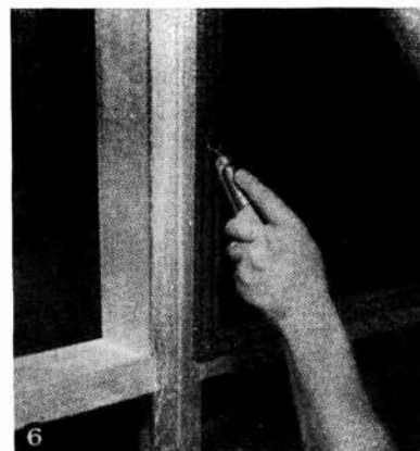
5.— Con una herramienta de mano, la tira es instalada en la ranura.
