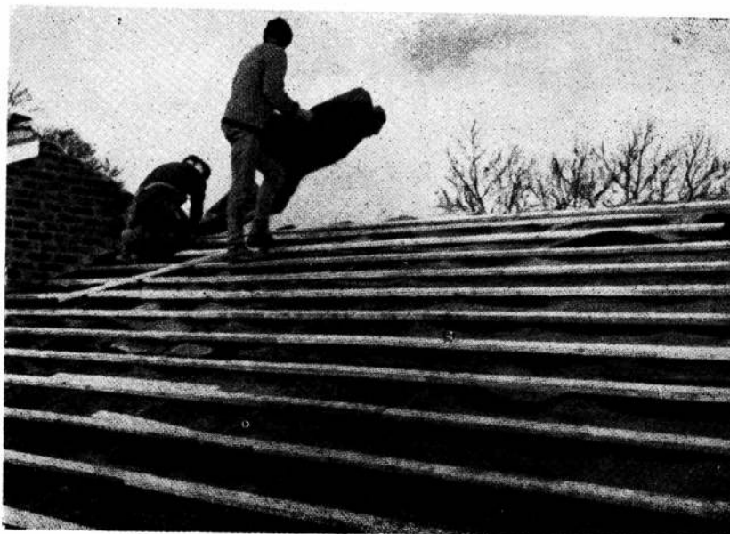
1.— Mediante películas de polietileno negro se asegura la impermeabilización de techos en pendiente.
