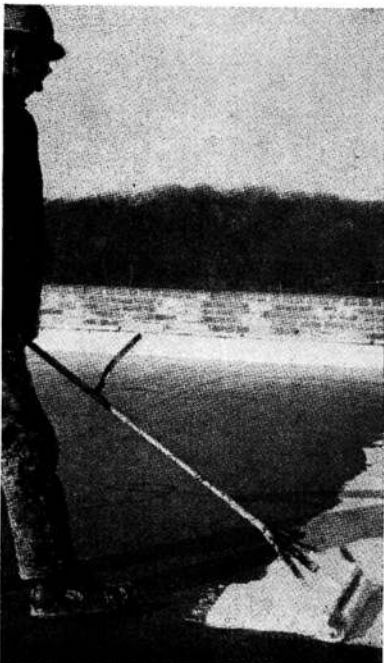
14.— Una capa de hypalon es extendida con rodillo simple sobre la superficie de neopreno.
