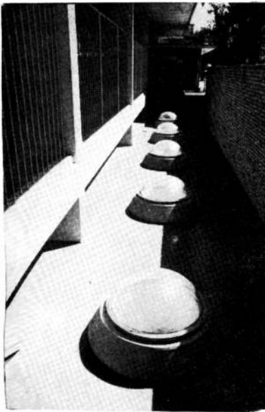
20.—Cúpulas para iluminación cenital instaladas en el Belgrano Day School (M. R. Alvarez y Asociados) y provistas por Modulor S.A.I.C.
