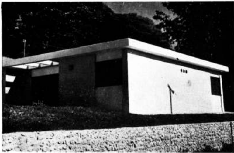
El pabellón de garage y servicio.
