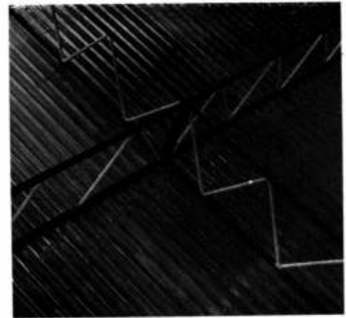
Armadura metólica del techo, con cubierta de chapas de aluminio.
