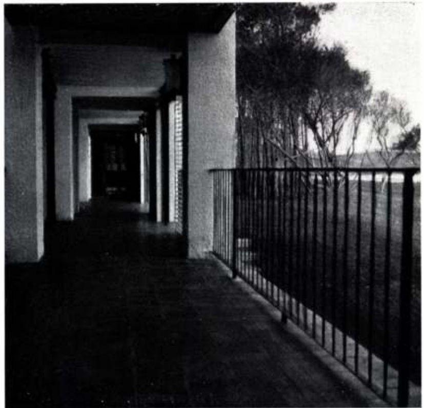
La galería de los dormitorios.
