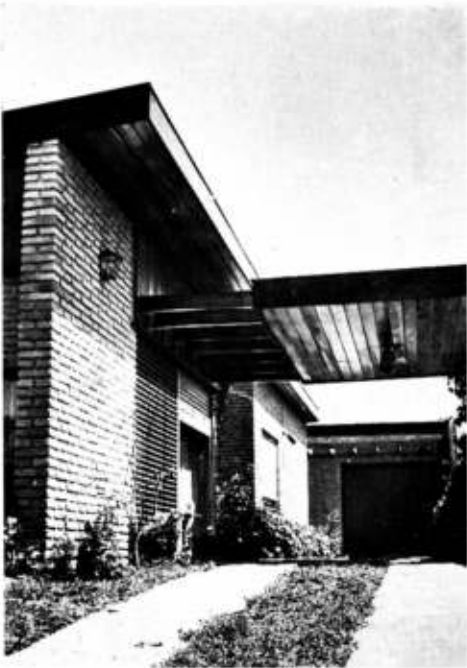
Pasaje de acceso al garage.
