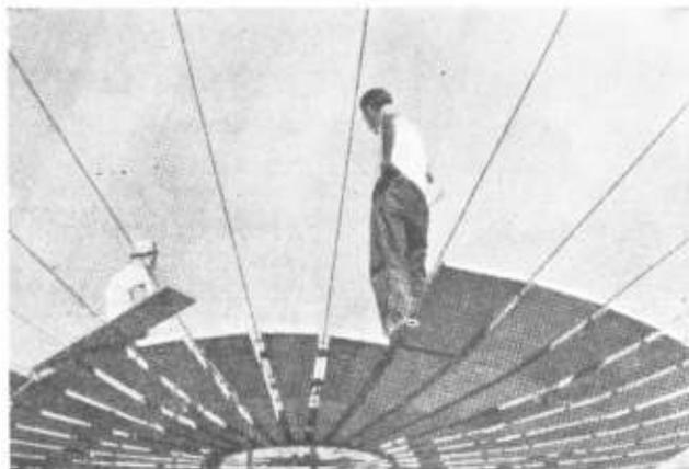
en los cimientos de cemento. El anillo externo se construyó conectando secciones prefabricadas de arcos laminados circulares de madera, disponibles en el mercado. Fueron reforzados por dos anillos de acero de sección angular. Fué una etapa difícil de la construcción y debió realizarse en taller. Los moldes de concreto se realizaron en el suelo no sin dificultades en cuanto a los refuerzos de acero.
