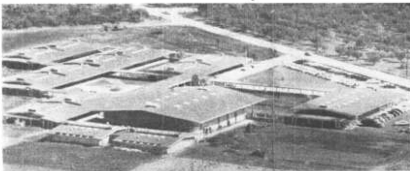
Vista de conjunto del Miramonte High School. Sólo el gimnasio cludió el ritmo de la unidad básica.
