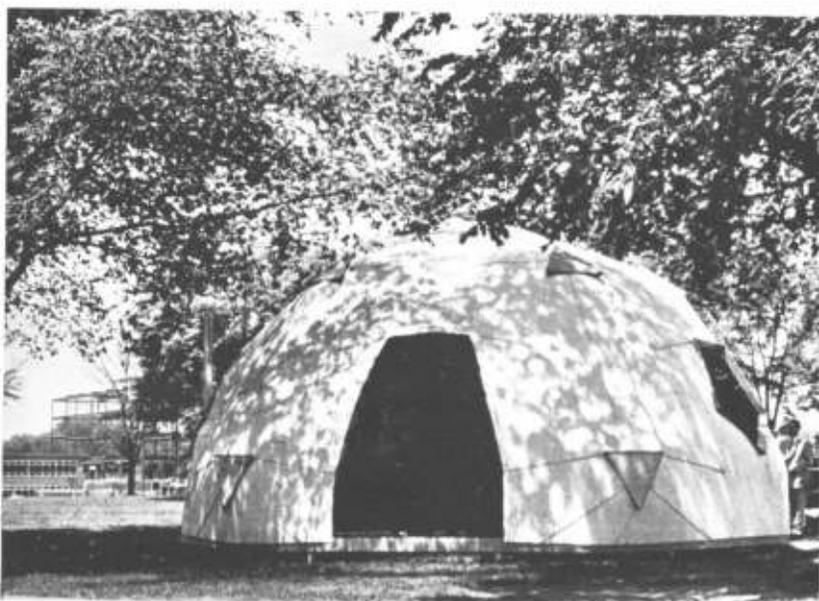
"Plydome" —cúpula en madera compensada—; su diámetro es de 12 metros y fué construída por estudiantes de la universidad de Columbia.
