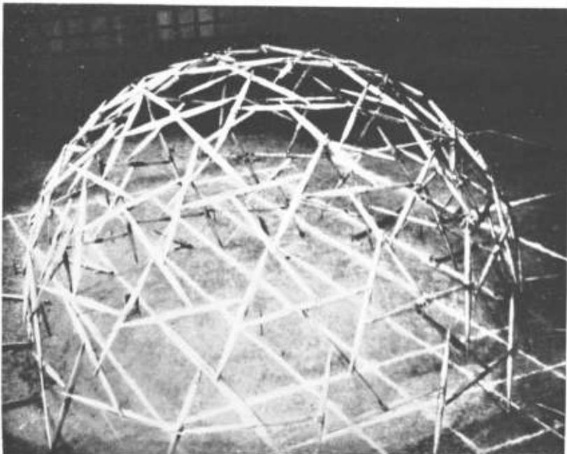
Cúpula esférica de 12 metros de diámetro; 270 elementos; tensión continuada; compresión discontinua.
