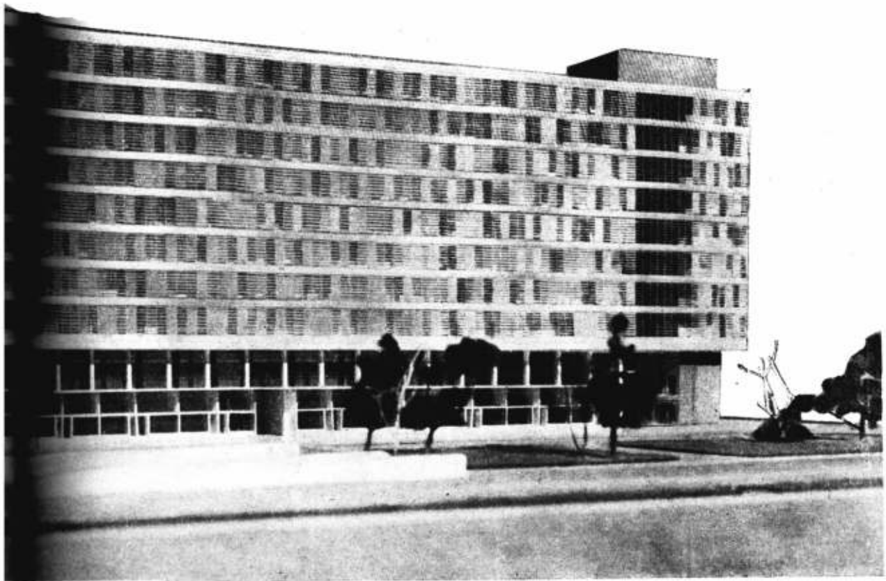
Fachada del nuevo Mercado del Plata sobre la Avenida 9 de Julio
