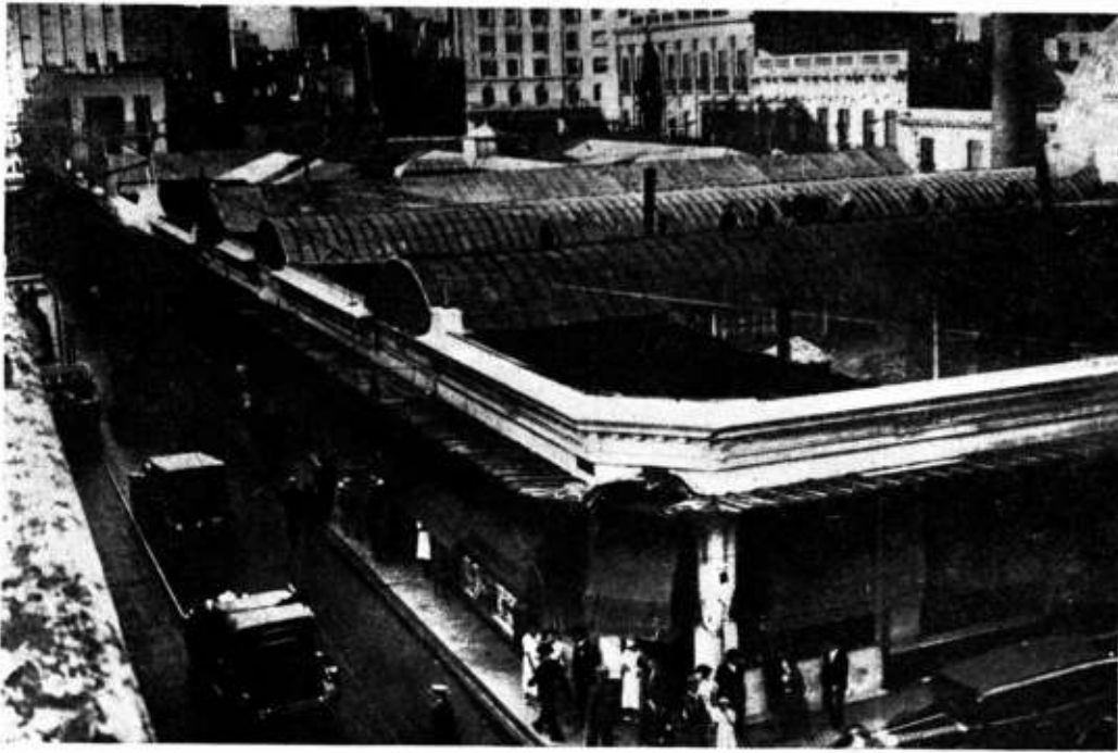
El mercado antes de su demolición, esquina Carlos Pellegrini y Cangallo
