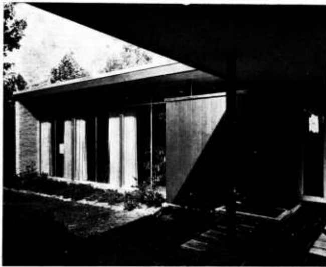
Frete Sur. Vista tomada desde la terraza exterior a la que abren el rincón de desayunos y las dependencias.
