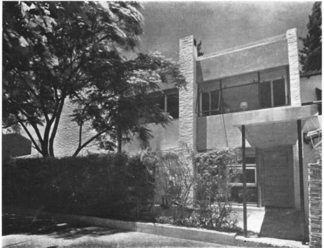
Vista de la entrada.
