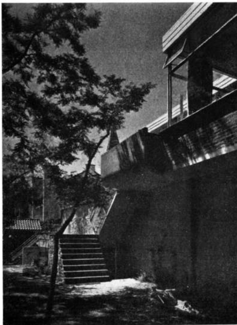
Vista de la escalera que une la terraza con el jardín posterior.
