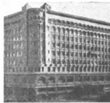
8.— 1909. En Silvertow, Inglaterra, Hennebique construye silos para cereales de 31 metros de alto y capacidad de 36.000 quintales.
