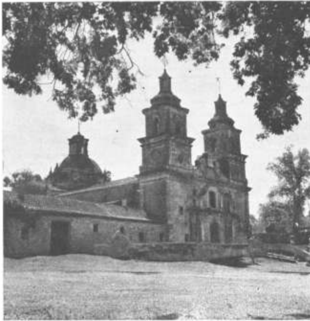
1 Vista general desde el sur-este.
