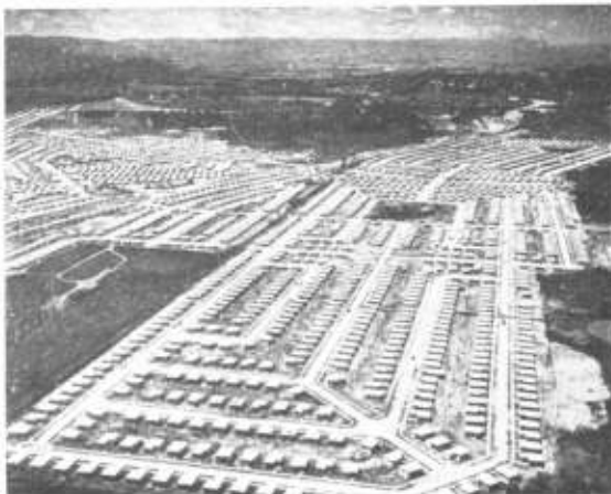
Vista aérea de la zona de Puerto Nuevo, en la cual han sido construidas 5.000 casas de cinco habitaciones cada una.
