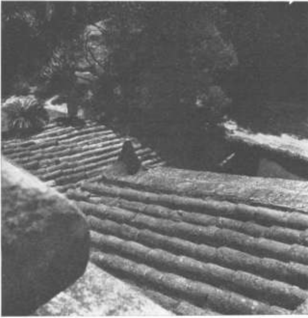
7 Pendiente de los techados hacia el lado norte.
