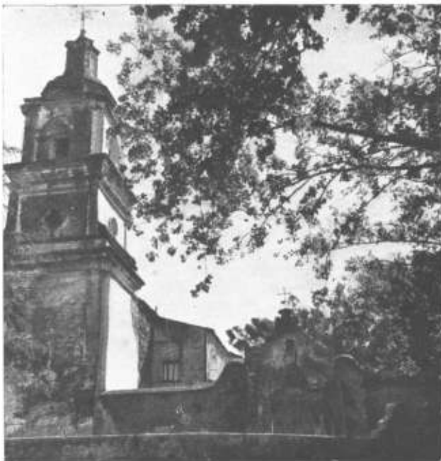
2 Torre derecha de fachada este y entrada al cementerio.
