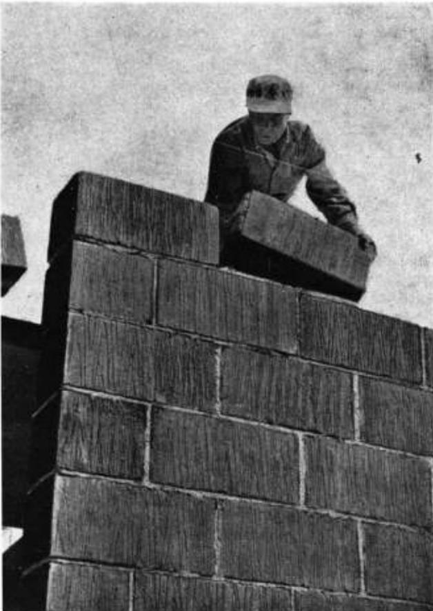
las planchas. En vista de que son muy fáciles de montar, ahorran mucho tiempo. Las placas de pared Ytong tienen una densidad de  $0.5 \text{ kg/dm}^3$ .
