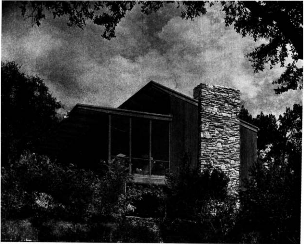
Angulo N.O. de la vivienda. Se aprecia la gran galería cubierta hacia la cual abren el living y el comedor; debajo de esta galería se ubicó el guardacoches aprovechando el desnivel del terreno.
