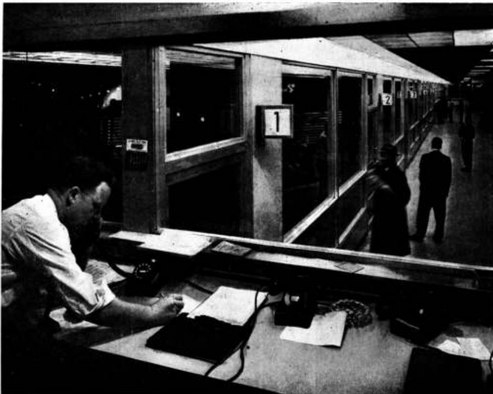
Vista de la oficina de control de tráfico desde donde se comanda todo el movimiento de la estación terminal.
