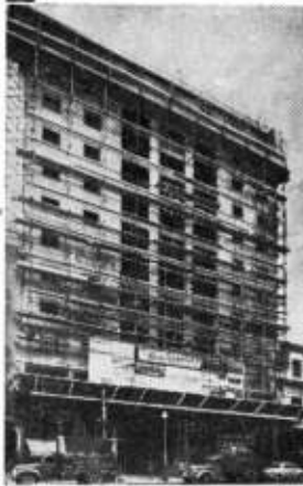
Obra Empresa Azian y Escorra Av. Santa Fe 1656 - Capital
