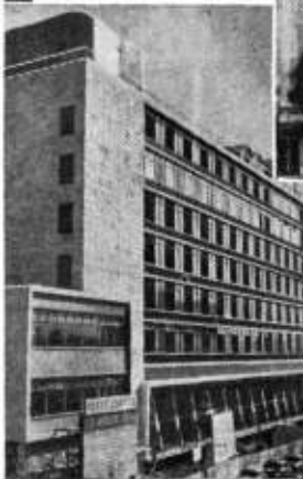
Empresa Benito Roggio e Hijos Palacio Correo y Telecomunicaciones - Córdoba
