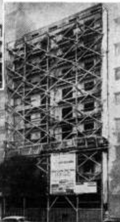
Obra Empresa Argentina Coneto Armado Paraná 1255 - Capital
