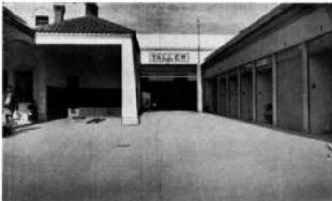
Un detalle de la estructura, como pilares y demás trabajos, se realizaron de hormigón armado.
