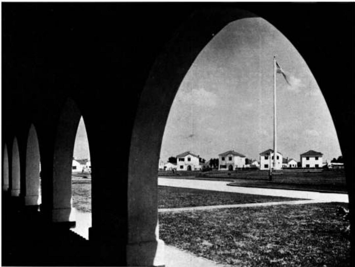
MASTIL BANDERA Y CONJUNTO DE CASAS TIPO A3 VISTO DESDE LA GALERIA DEL SALON DE ACTOS
