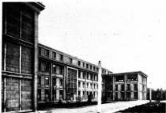
Servicio Técnico de las Construcciones Navales Fachada posterior
