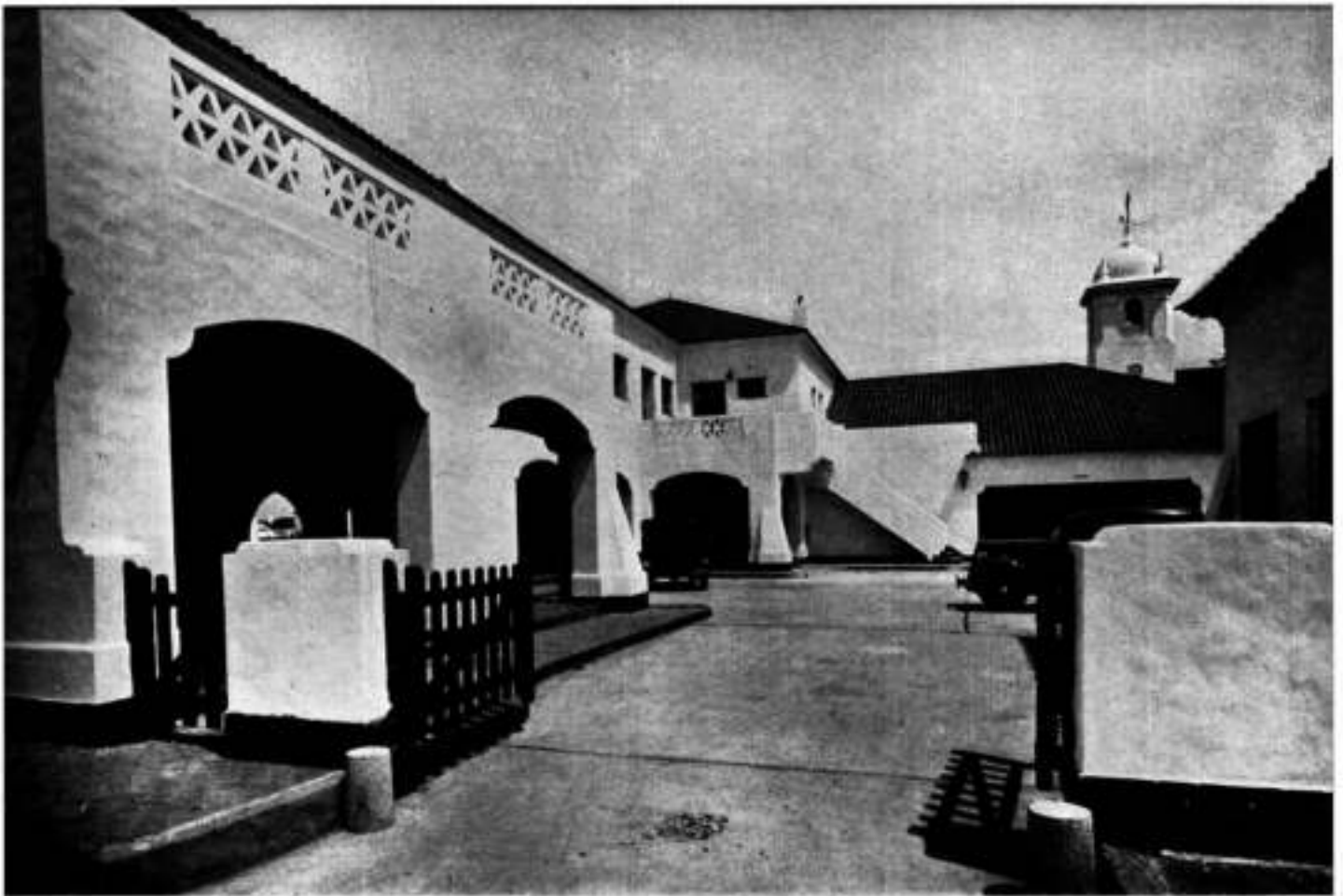
ENTRADA GARAGE Y PATIO DE LA PROVEEDURIA
