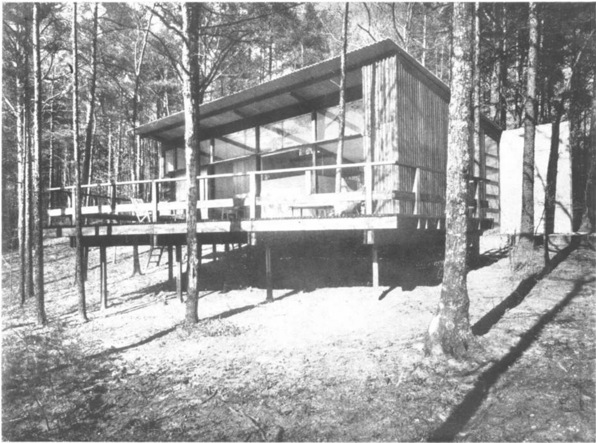
Fachada sud-oeste. Obsérvese la gran continuidad con el paisaje que se logró dar a esta vivienda mediante el uso franco de materiales de construcción muy simples.
