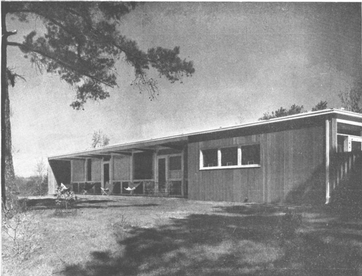
Fachada sur vista desde el ángulo sudeste.
