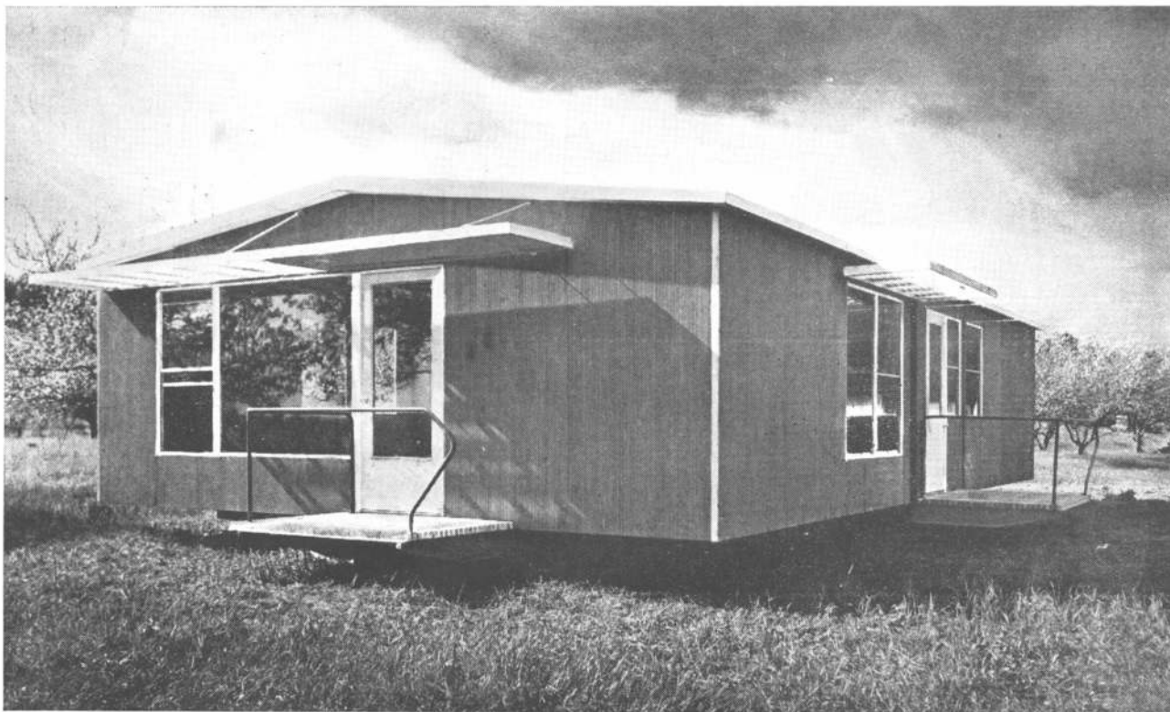
La casa ya erigida sobre su liviana base de acero.
