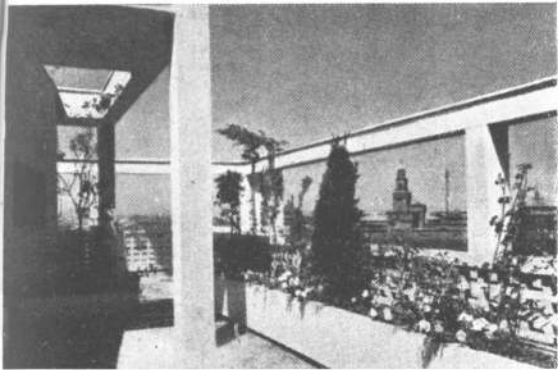
Un aspecto de una terraza que da hacia el jardín, mostrando la estructura de cemento armado separada de la construcción útil.
