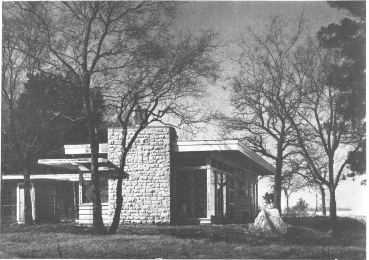
Vista desde el este, mostrando la pared de piedra correspondiente a la chimenea y los ventanales del living. A la derecha, separada de la casa, se ha construido una casilla vestuario para cambiarse en verano los nadadores.
