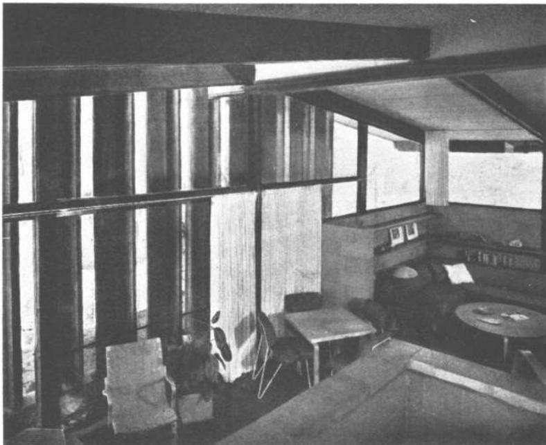
Desde el comedor, colocado más alto, se observan distintos rincones del living, en el cual se han dejado a la vista todos los integrantes de la estructura. En la pared frontal del living, por su parte exterior, se han colocado varias vigas de madera en forma T verticalmente para interceptar el fuerte sol y brindar un elemento decorativo.
