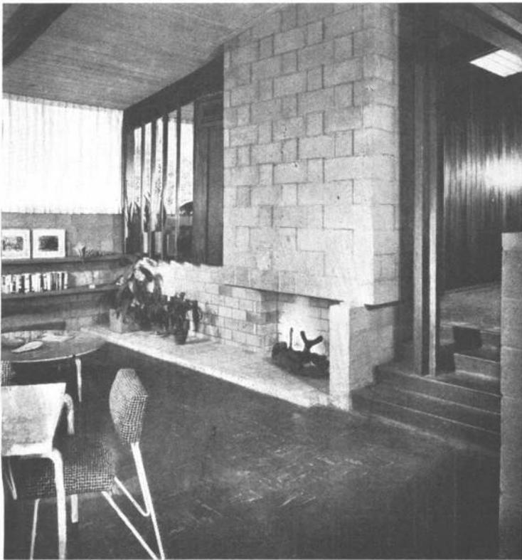
Un aspecto del living. La ventana interior de madera comunica con el escritorio. El pasillo de la derecha conduce a los dormitorios. Tanto en los interiores como en los exteriores se ha utilizado en gran escala bloques de cemento tratados con ácido en su superficie para darles coloración y textura apropiadas.
