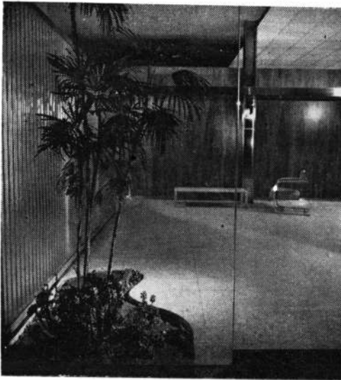
Un hall jardinizado con piso de mosaico veneciano, separado a la izquierda del hall de escalera mediante un cristal tratado al ácido y al fondo de las oficinas interiores mediante un tabique de nogal. Las puertas son de vidrio templado, sin marco.
