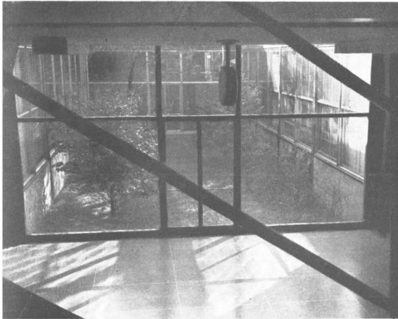
Patio interno del edificio de Ingeniería Metalúrgica y Química visto desde la caja de escalera.
