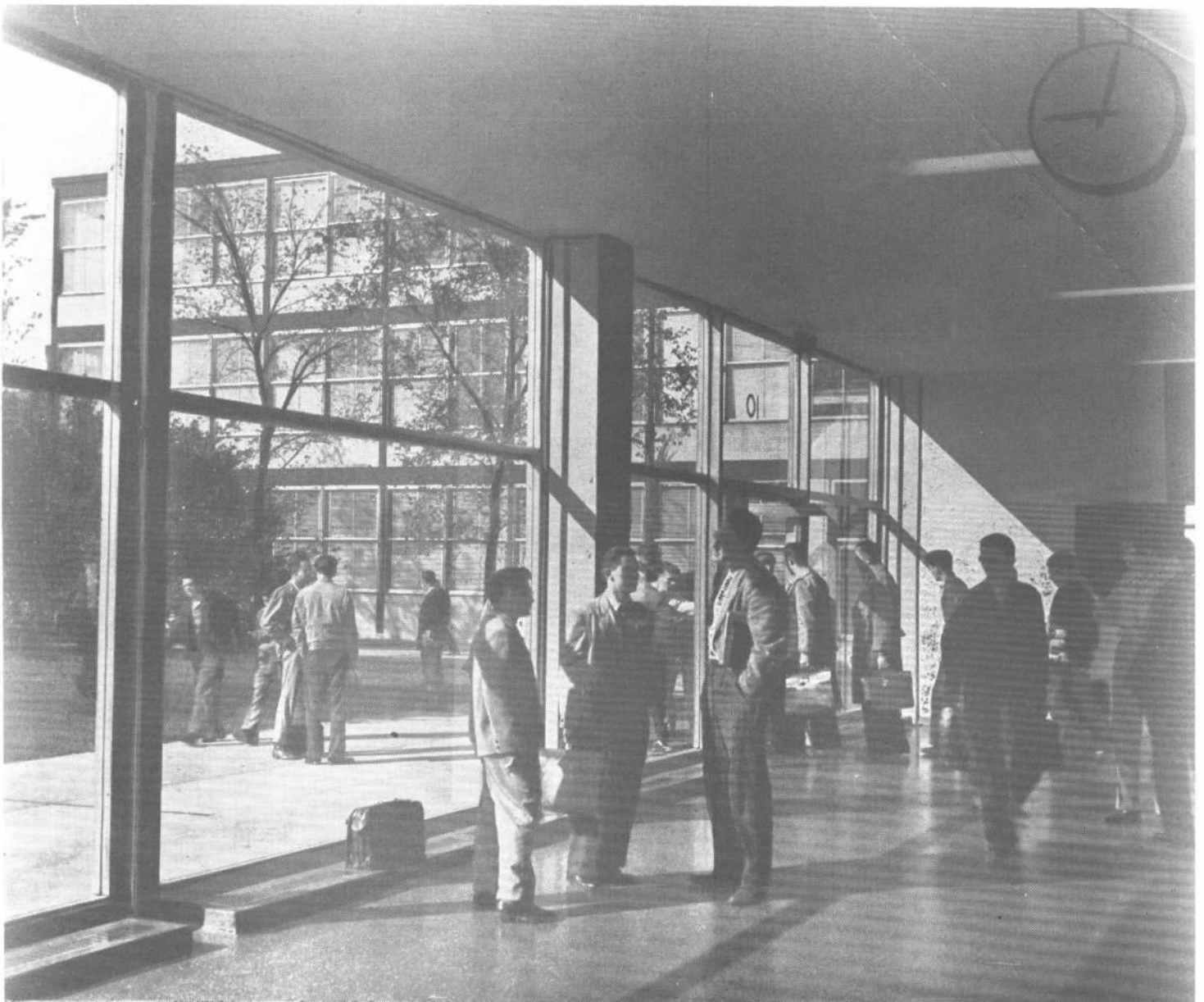
Edificio de ingeniería Metalúrgica y Química. El vestíbulo de entrada; al fondo el Chemistry Building.
